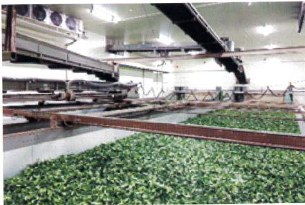
図1 低温保管装置内部
